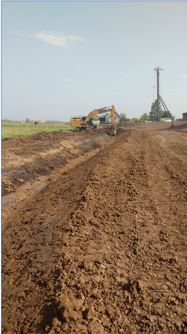
Figuur 2. Overzicht van de werkzaamheden bij het uitgraven van de sloot in deelgebied A.
